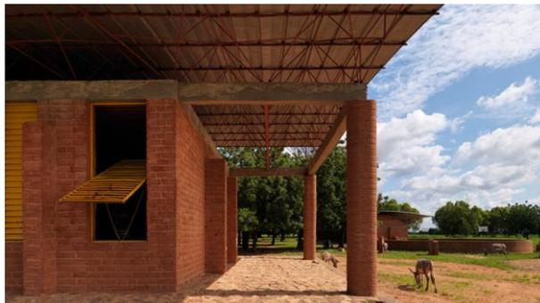
**Figura 1** – Escola Primária de Gando, mostrando a estrutura ventilada e o uso de materiais locais.
