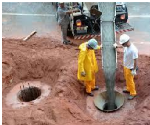
Figura 2 – Representação de operários fazendo enchimento de concreto na fundação profunda. ( https://www.google.com.br/search?q=fundações+rasas+e+profundas&source=lnms&tbm=isch&sa=x&ved=0ahukewif747i34rtahugpakhuzejboeq_auiiccgb#tbm=isc&q=fundações+profundas&*imgsrc=q9fehbpabzkdfm )
