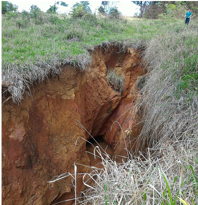
Figura 1: Profundidade da erosão
