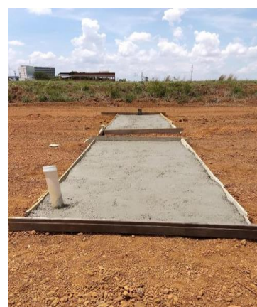
Figuras 6 – Pavimento finalizado Fonte: Autor (2021)
