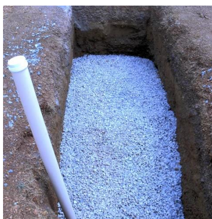
Figuras 4 – Camada de brita 2 Fonte: Autor (2021)
