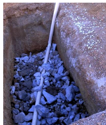
Figuras 3 – Enroncamento Fonte: Autor (2021)
