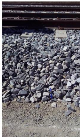
Figura 2. Perfil esquemático do pavimento férreo, composto de dormentes/trilhos, camadas de lastro e sublastro, situado no pátio de manobras da ferrovia.
