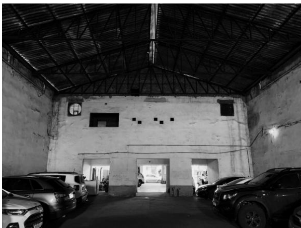
Figura 3: Interior da antiga sala de projeção do Cine Santa Maria em abril de 2024.
