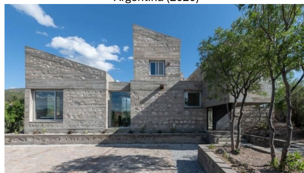
Figura 04 – Casa DP, Nanzer + Vitas, Capilla del Monte, Argentina (2020)
