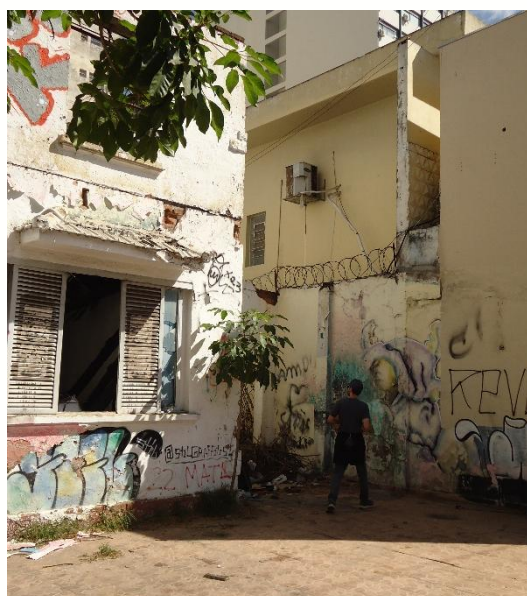
Deriva pela rua 07, nas proximidades da Praça Cívica.
