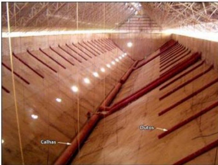
**Figura 1-** Graneleiro fundo v, com calhas, cabos termométricos e dutos de aeração.
