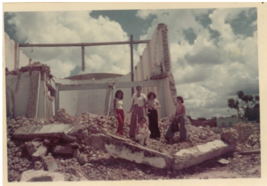
Figura 03. Destruição de Igreja Católica, para construção de uma nova Igreja. Obs: no mesmo lugar da foto anterior. Fotografia da década de 1970. Acervo particular: Fotógrafo: Desconhecido.
