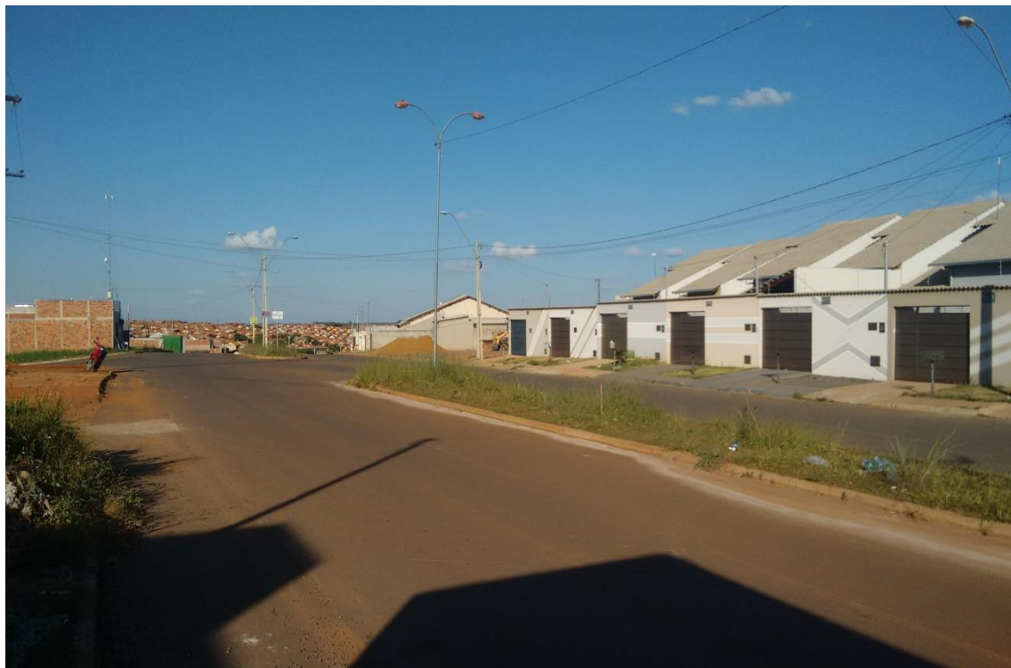
Foto 5 – Av. Ilha Formosa, conjunto habitacional ao fundo e construções mais recentes e áreas livres para novos empreendimentos a frente, Residencial Leblon, Anápolis/GO, 2019
