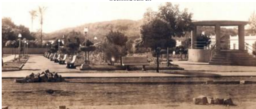
FIGURA 02 – Reforma do Coreto, iluminação e calçamento Praça da República de Itumbiara.
