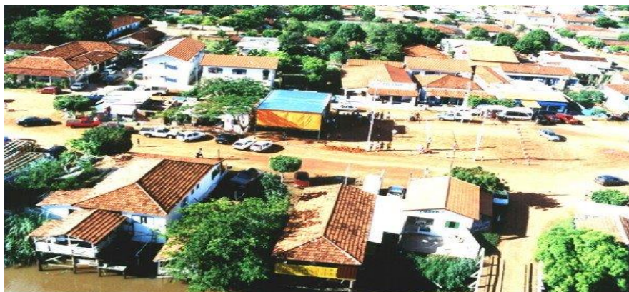
Figura 5 - Imóveis utilizados como residências e comércio
