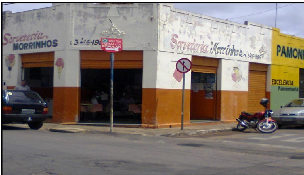
Imagem 5: Sorveteria Morrinhos, esquina da Rua Barão do Rio Branco com a Major Limírio, em Morrinhos (GO)
