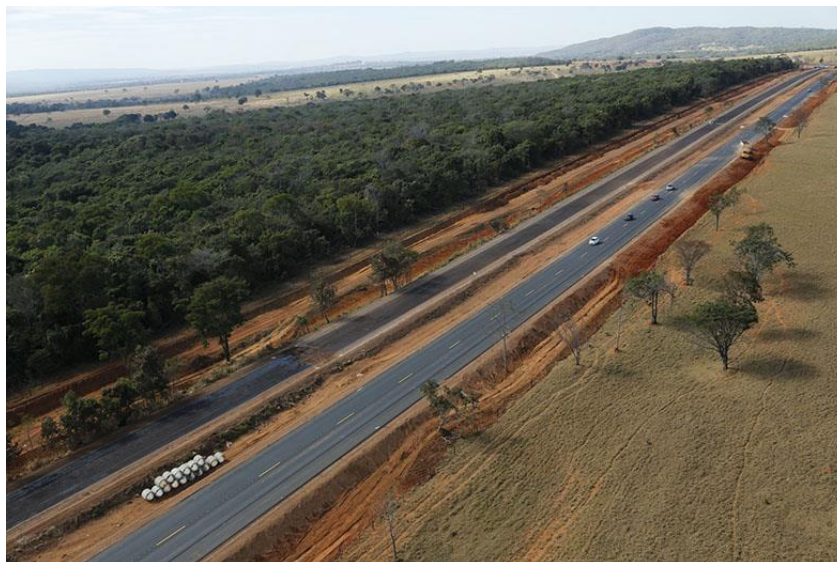
Figura 2 – Duplicação sem nenhuma medida mitigadora para passagem de fauna
