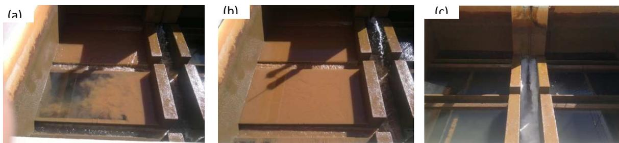
**Figura 3** – (a) início da lavagem do filtro, (b) evolução do processo de lavagem e (c) etapa final da lavagem de filtros da ETA Anápolis.
