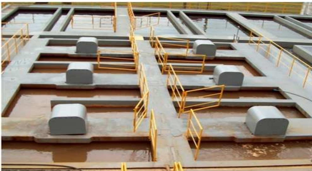
**Figura 2** - Série de floculadores com impulsores rotativos de eixo vertical e decantadores próximos aos floculadores, ETA Anápolis/GO.
